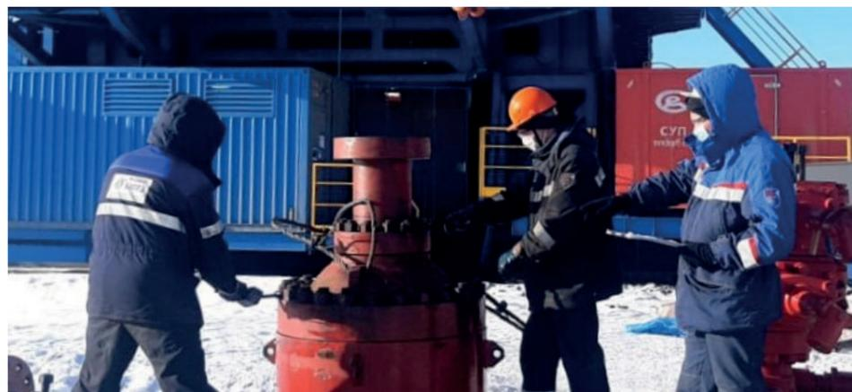
Подготовка ствольной части ПВО к установке на устье скважины
